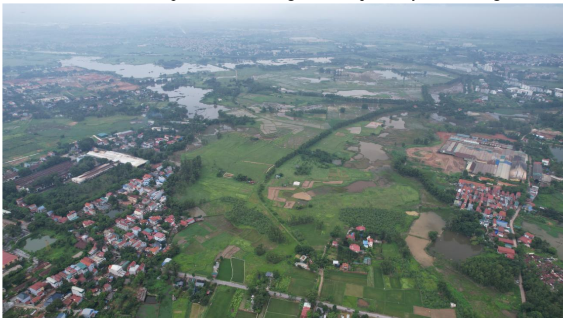
Hình 1.1. Cảnh quan hiện trạng tại khu vực dự án Đầu tư xây dựng hạ tầng kỹ thuật KCN Sạch Sốt Sơn
