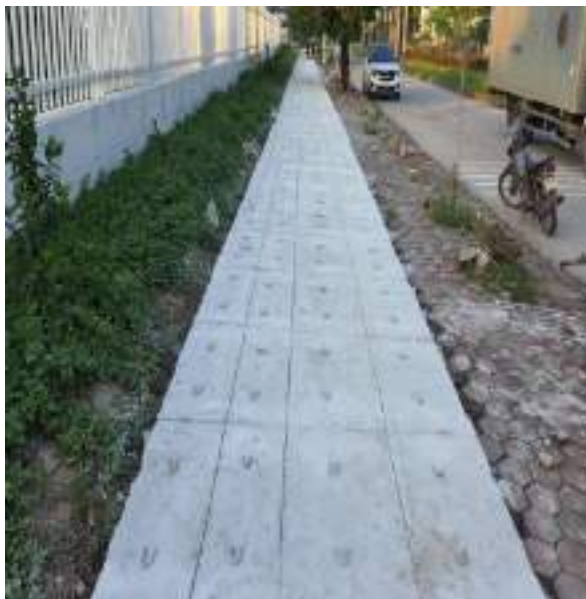
Hình 3.2: Hình ảnh kênh thoát nước mưa của khu công nghiệp
