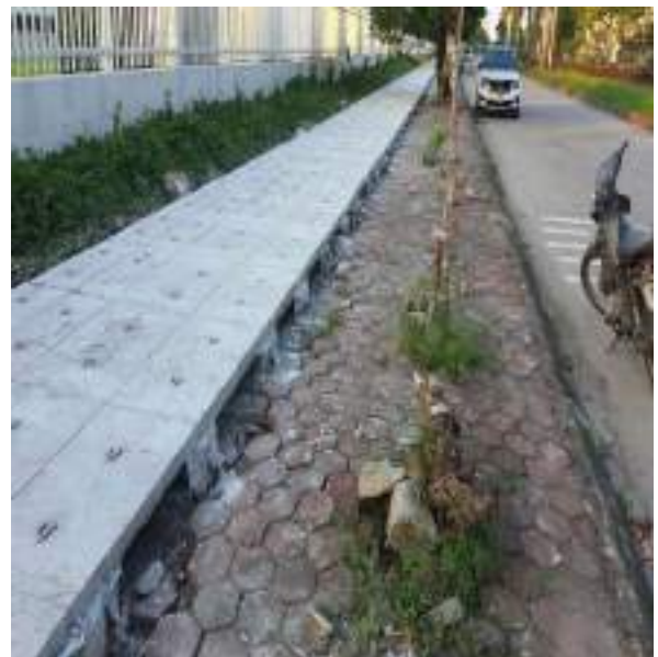
Hình 3.2: Hình ảnh kênh thoát nước mưa của khu công nghiệp
