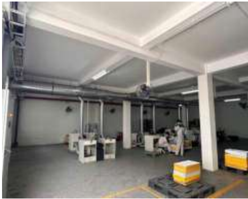
Hình 2.12. ảnh hiện trạng hệ thống thu gom, XLKT tại dây chuyền phốt 1 2, Hệ thống thu gom và xử lý bụi dây chuyền phốt 02 (HTXLKT02)
