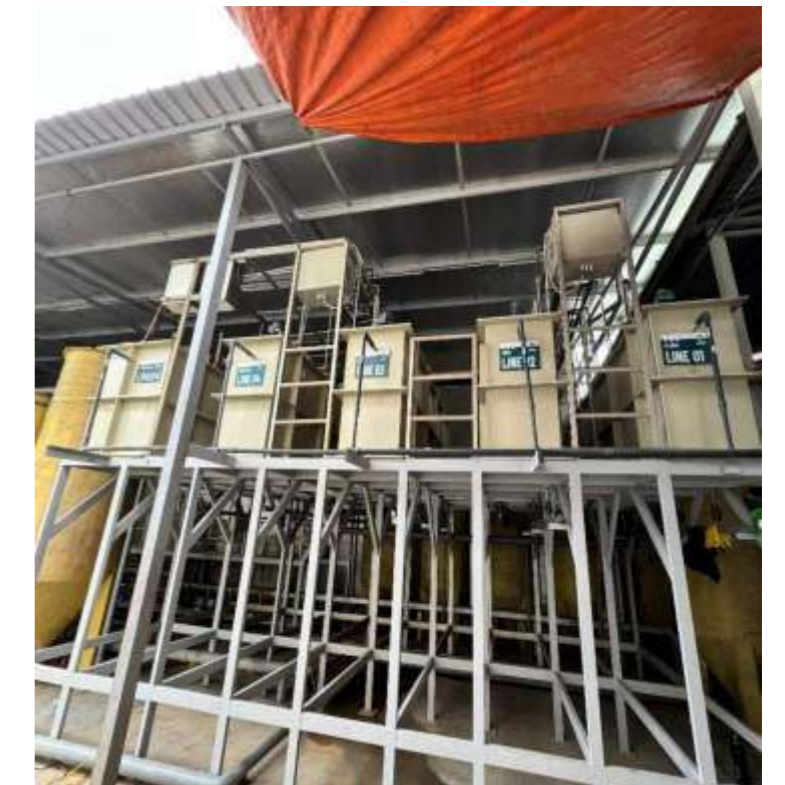
Hình 1.7. Khu vực trạm xử lý nước thải tập trung
