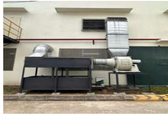
Hình 2.12. ảnh hiện trạng hệ thống thu gom, XLKT tại dây chuyền phốt 1 2, Hệ thống thu gom và xử lý bụi dây chuyền phốt 02 (HTXLKT02)
