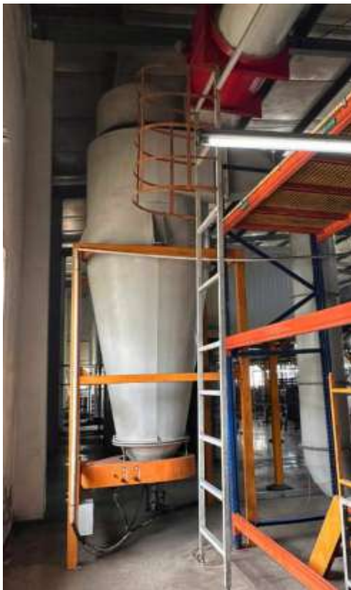
Hình 2.26. Ảnh hiện trạng hệ thống thu gom, XLKT tại buồng sơn tự động
