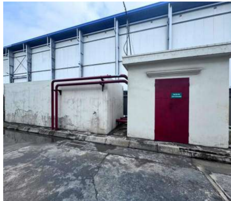
Hình 1.6. Nhà để máy bơm PCCC
