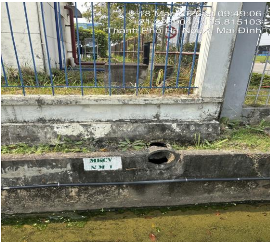
(Điểm thoát nước mặt số 1)
