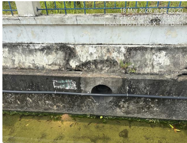
(Điểm thoát nước mặt số 2)
