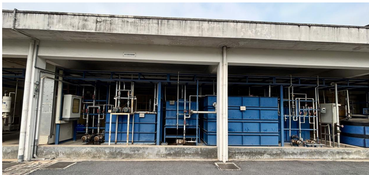
Hình 3.15. Hệ thống xử lý nước thải sản xuất công suất 8 m 3 /ngày đêm
