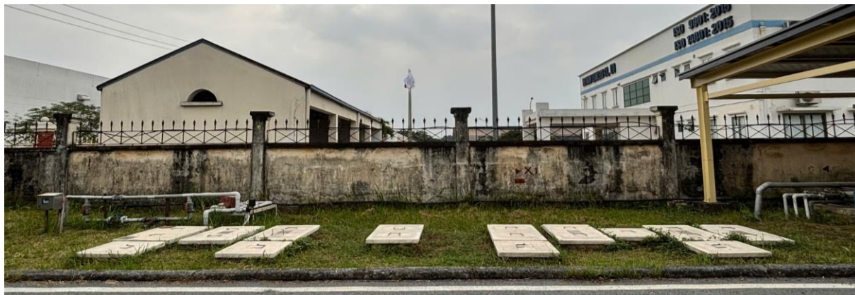
(Tổng thể các bể xử lý nước thải sinh hoạt – được bố trí ngầm)
