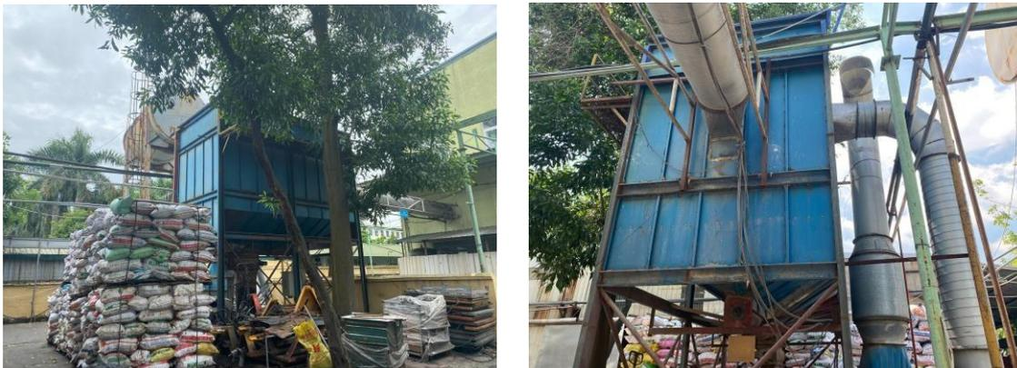
**Hình 20: Hình ảnh hệ thống xử lý khí thải dây truyền sơn UV**
