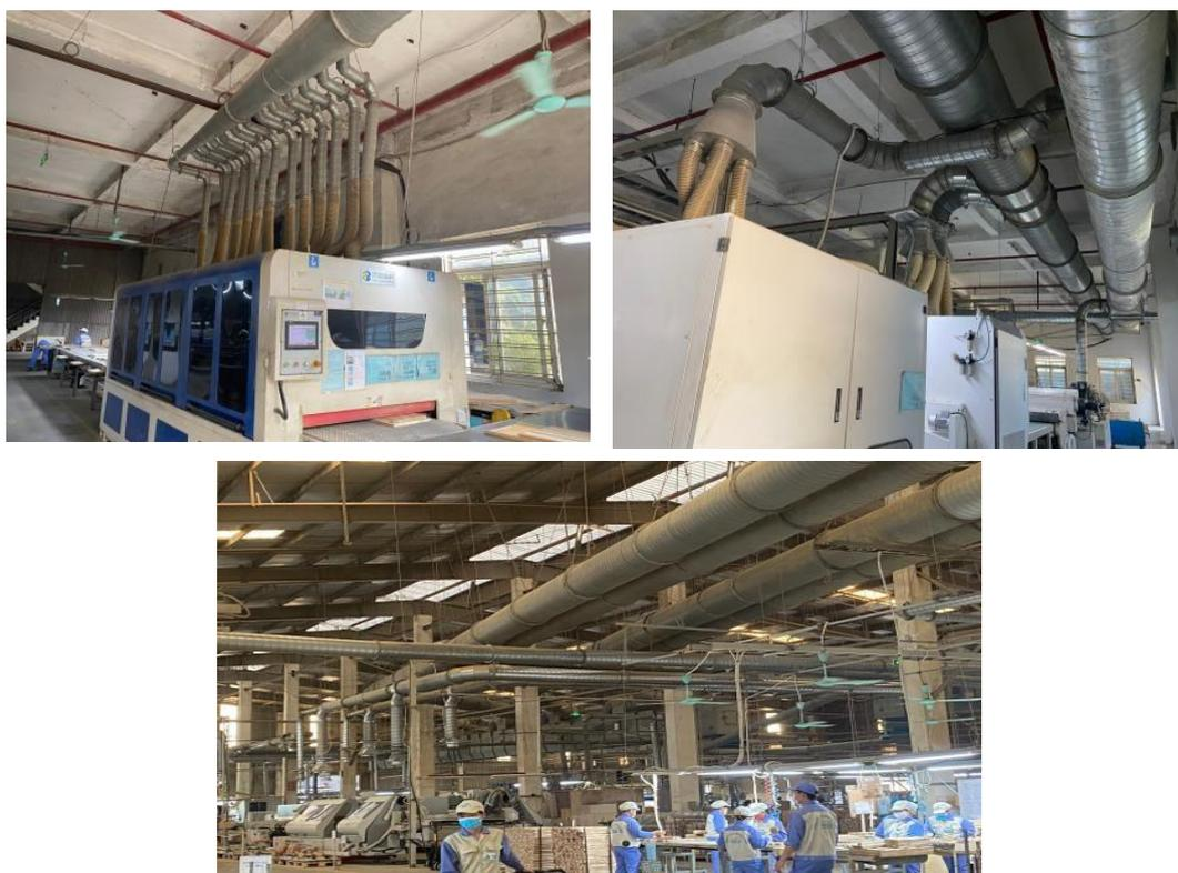
**Hình 14: Hình ảnh hệ thống thu hút bụi từ máy gia công gỗ**
