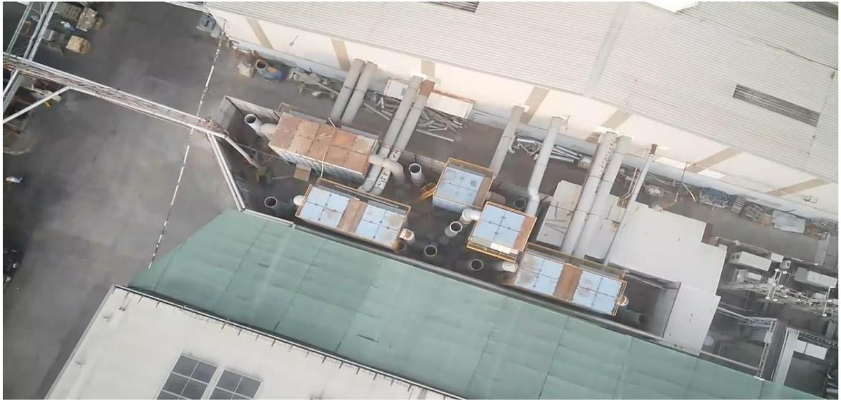
**Hình 15: Hình ảnh hệ thống lọc bụi túi vải sau xưởng 1**
