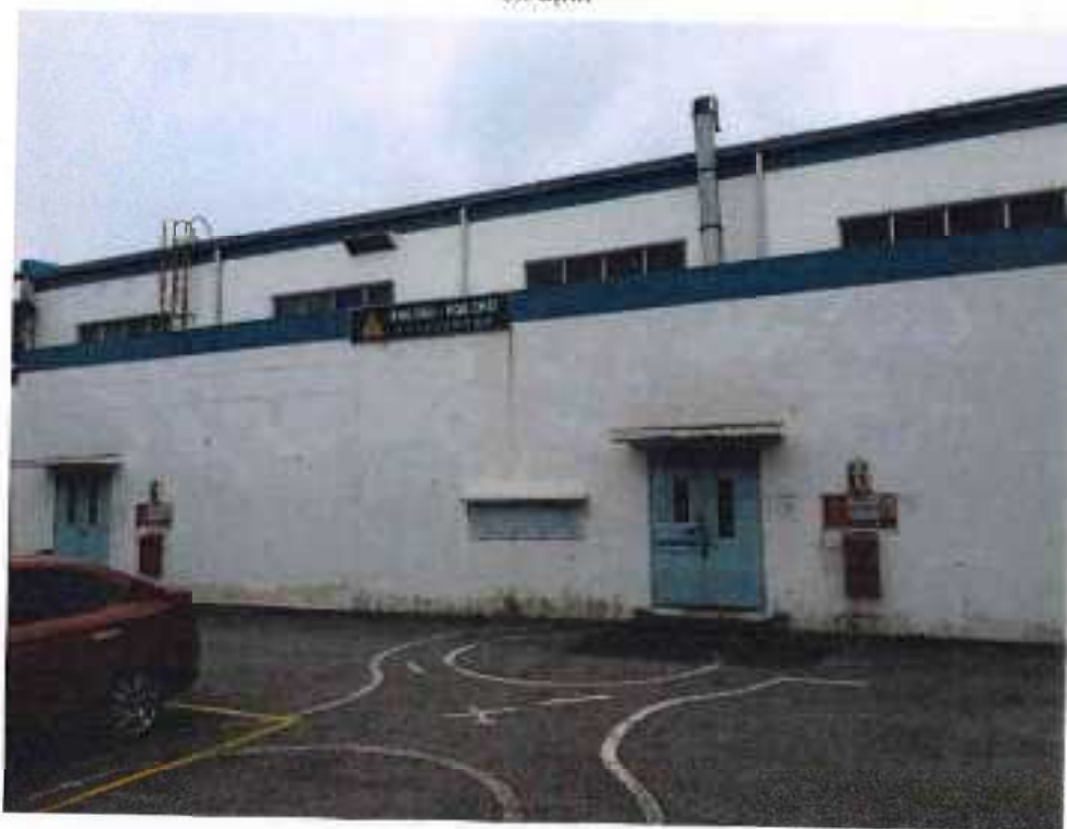
Hình ảnh kho hóa chất của Nhà máy
