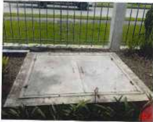
Hình 6 Hình ảnh hố ga thoát nước mưa của cơ sở
