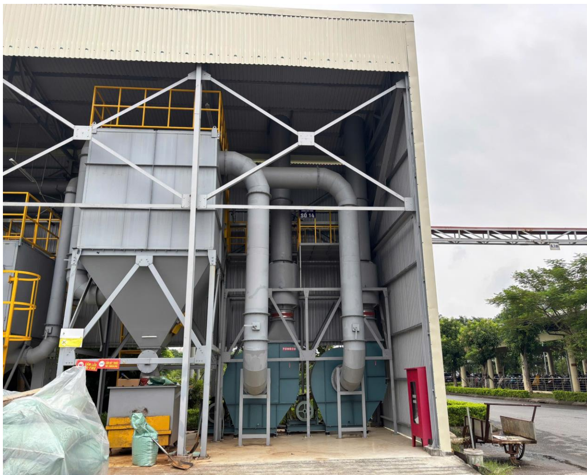
Hình 3.15. Hình ảnh hệ thống xử lý bụi từ hệ thống cấp sợi tổ hợp trung tâm của Phân xưởng Hợp tác quốc tế và Phân xưởng Cuốn điều – Đóng bao mở rộng
