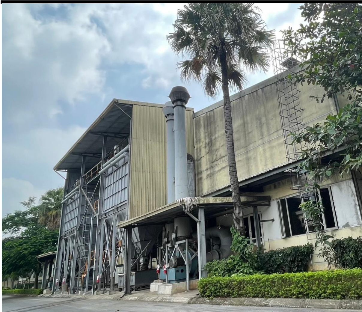
Hình 1.3. Hệ thống hút lọc bụi nguyên liệu sợi (thuộc Hệ thống cấp sợi) của Phân xưởng Cuốn Điều - Đóng bao
