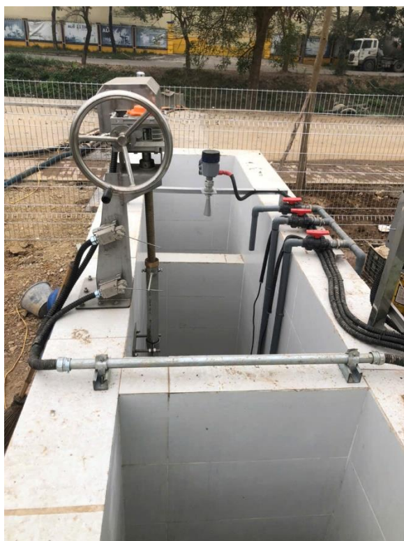
Kênh hở đo lưu lượng nước thải sau xử lý (có lắp đặt thiết bị quan trắc tự động)
