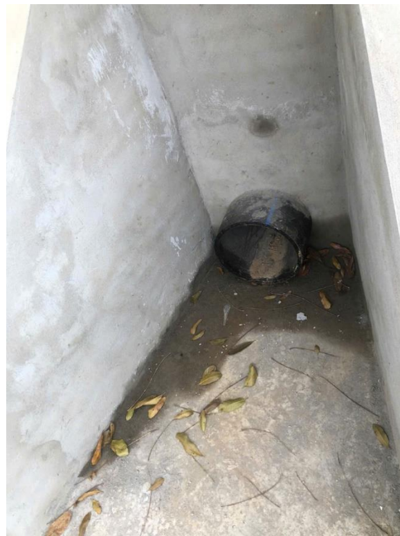
Kênh hở đo lưu lượng nước thải sau xử lý (có lắp đặt thiết bị quan trắc tự động)
