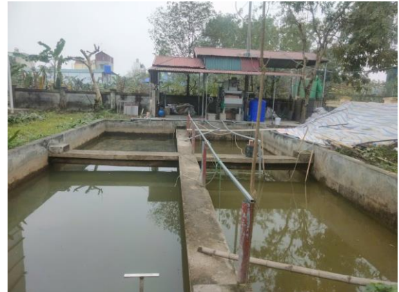
Bể sơ lắng (chứa nước thải từ quá trình rửa lọc) 370,435m 3
