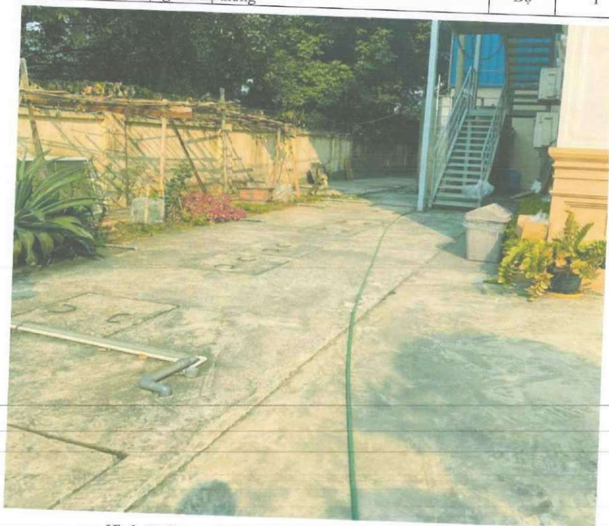
Hình 13 Trạm xử lý nước thải công suất 20 m 3 /ngày đêm
