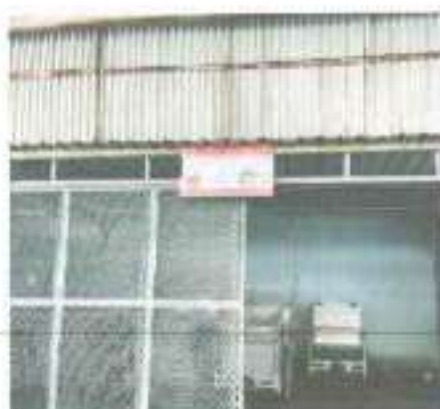
Hình 33 Hình ảnh kho chứa rác thải sinh hoạt
