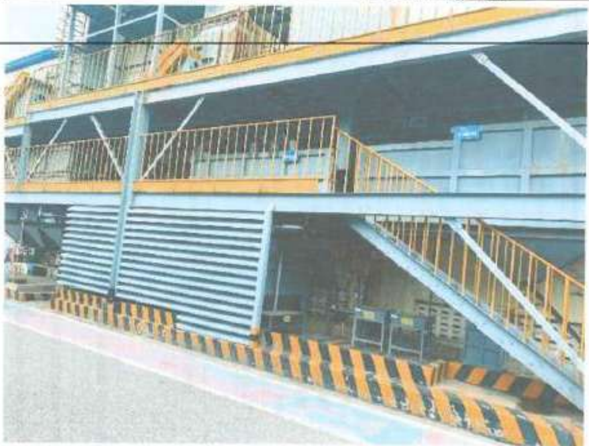
Hình 14 Hệ thống xử lý nước thải sản xuất công suất 15 m 3 /ngày đêm
