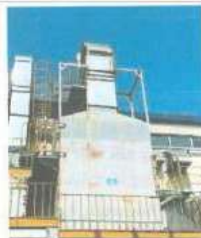
Hình 32 Hình ảnh phòng dân chân gỗ và hộp hấp phụ than hoạt tính
