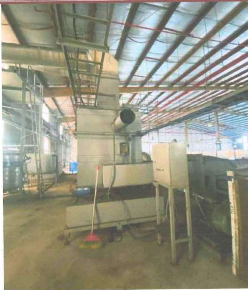
Hình 23. Hệ thống thu gom tháp xử lý số 2
