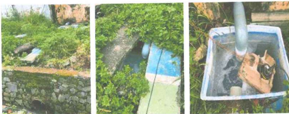
Hình 16. Hồ ga cuối thoát nước thải sản xuất của cơ sở
