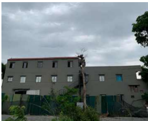
Hình 1. 2. Nhà kho hiện trạng
