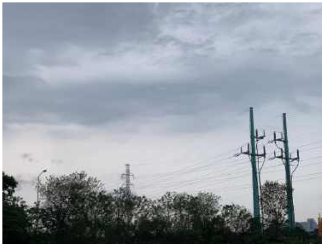
Hình 1. 6. Đường điện 110kv qua khu vực dự án
